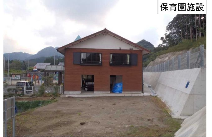
宮崎県宮崎市鏡洲地区 急傾斜地崩壊防止施設 (重力式擁壁)
