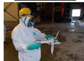
建屋内放射能濃度測定状況
