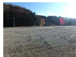
保管汚泥処理完了
