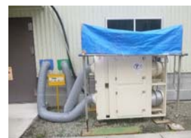
負圧集塵機設置状況
