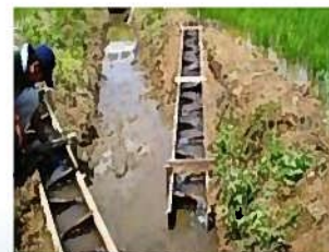
水田魚道の設置
