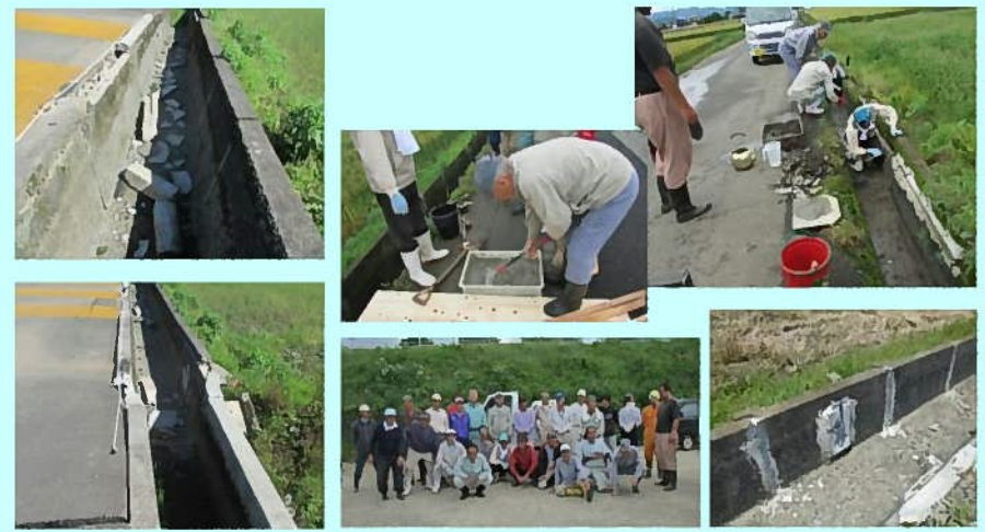
農地周りの水路の被災状況 活動組織による被災水路の応急措置や復旧
