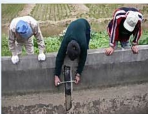
施設の機能診断
