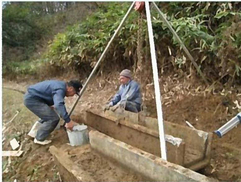
直営施工による水路補修
