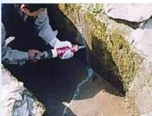
水路のひび割れ補修
