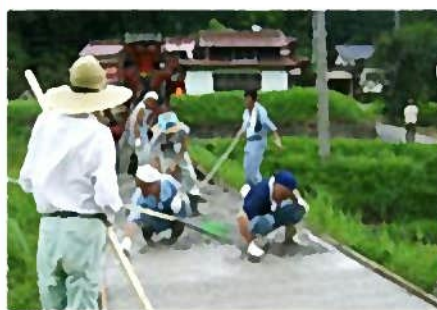
集落間連携による農道の舗装
