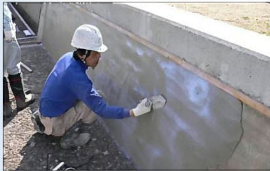
老朽化した水路壁のコーティング
