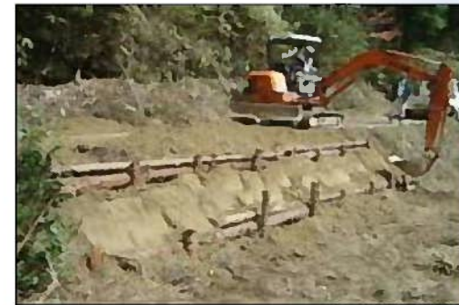
農道路肩、農道法面の補修
