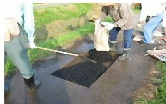
農道の補修(対象組織が実施)
