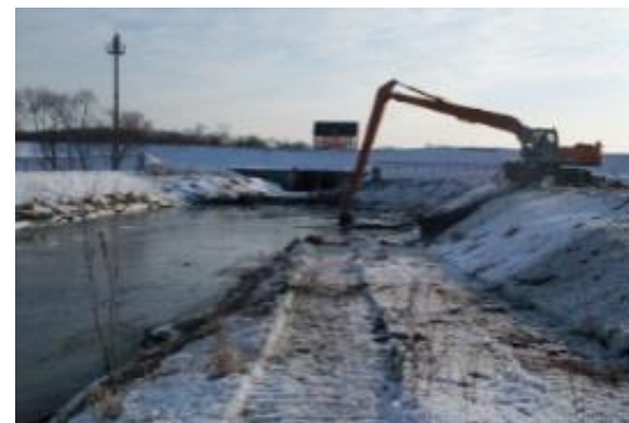
草地からの排水路 に設置した沈砂池の土砂上げ
