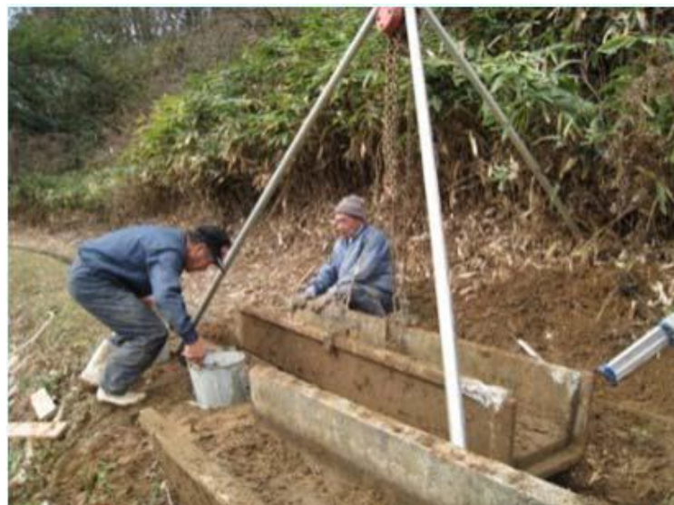
直営施工による水路補修
