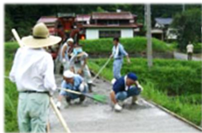
集落間連携による農道の舗装
