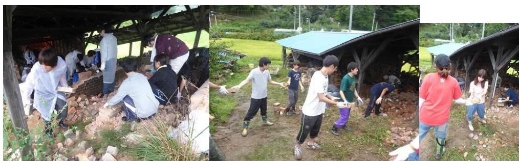
三渡窯のレンガ撤去作業
