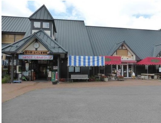
道の駅・ふくしま東和あぶくま館
