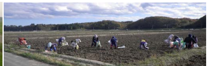
人力によるガレキ除去作業
