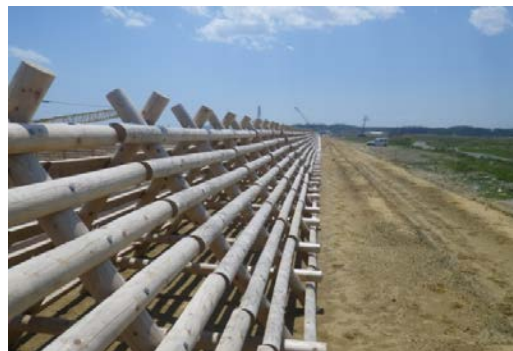
防風柵の設置状況
