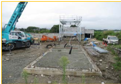
工事の様子（ふ化施設等）
