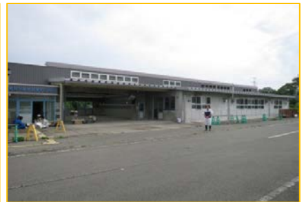
工事の様子（事務所・加工所）
