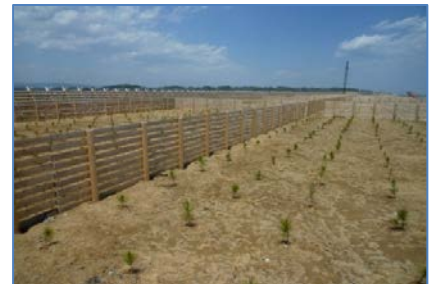
静砂垣と植栽状況
