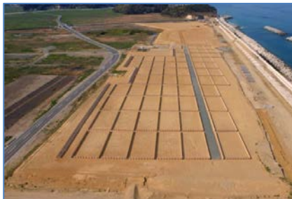
防風柵・静砂垣が設置された海岸防災林 (南相馬市鹿島区)
