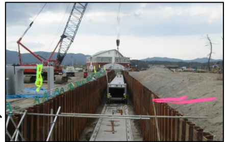
排水管設置工事
