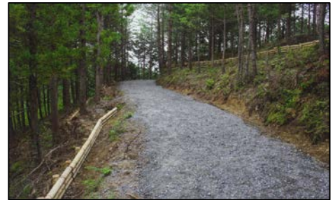
放射性物質拡散防止柵工（丸太柵工）
