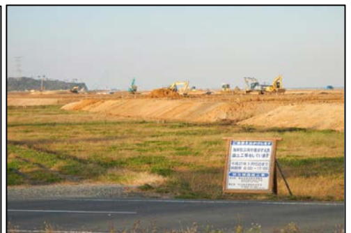
植生基盤盛土状況（原町地区）
