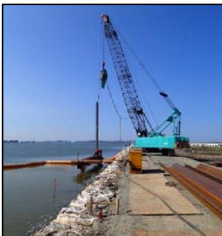
鋼矢板施工状況（大洲地区）
