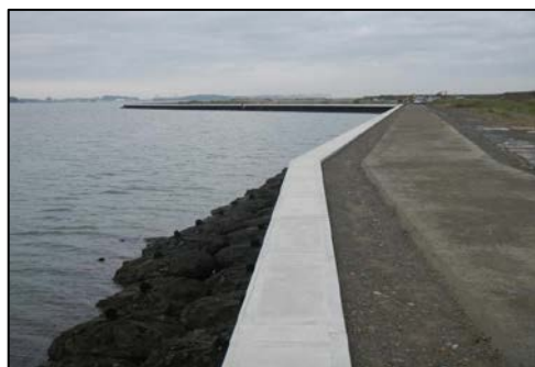
護岸堤防完成状況（大洲地区）
