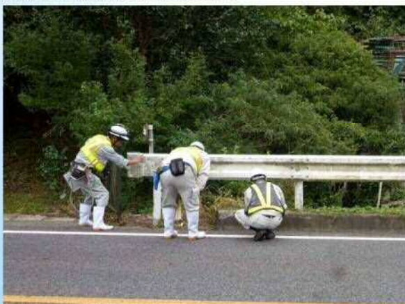
路面の損傷確認状況
