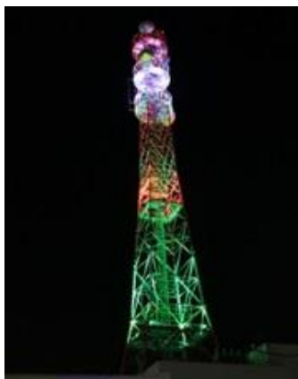
① 福島営業所構内無線鉄塔のライトアップ
