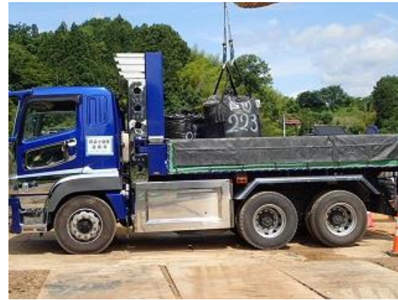
除去土壌等の積み込み作業確認
