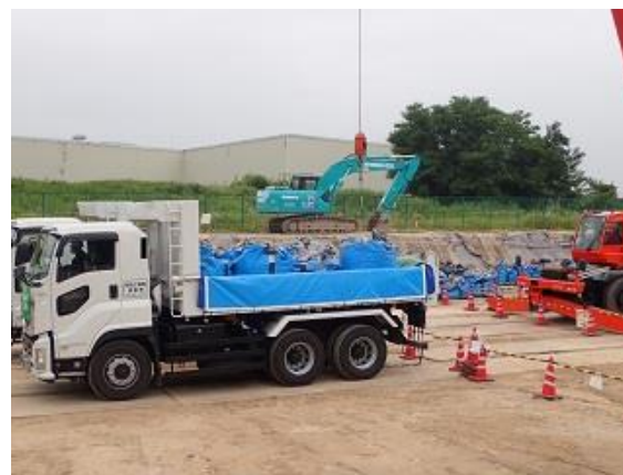
除去土壌等の積み込み作業確認
