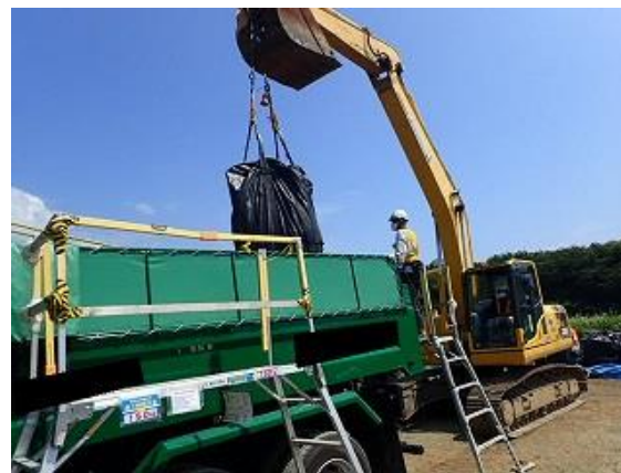
除去土壌等の積み込み作業確認
