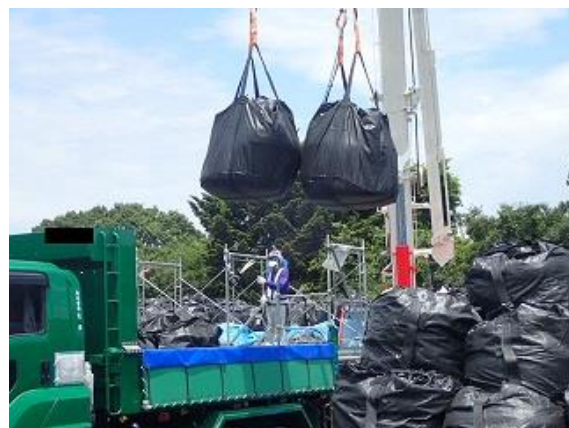
除去土壌等の積下ろし作業確認
