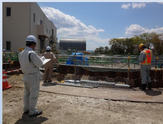
落下防止のための仮設設備点検状況
