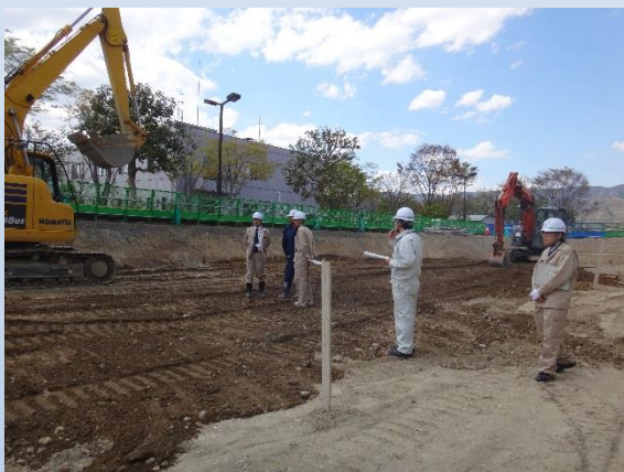
建設機械の誘導・合図の点検状況
