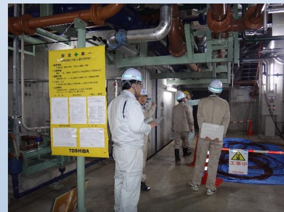
工事現場の整理整頓、進入防止柵等の点検状況
