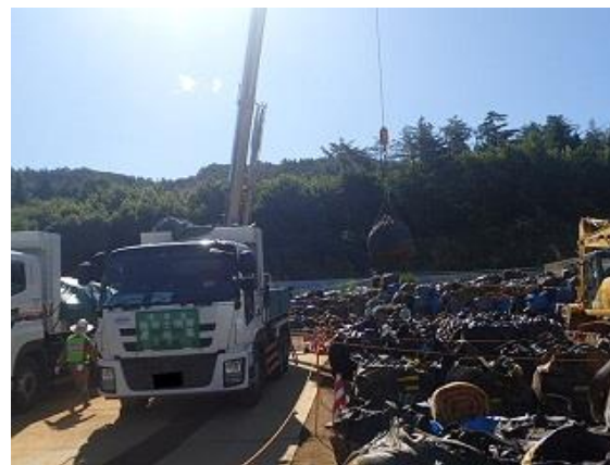
除去土壌等の積み込み作業確認
