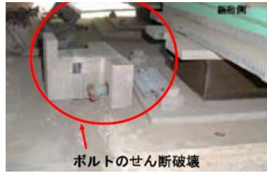
アンカーボルトのせん断破壊 (ゴム支承)
