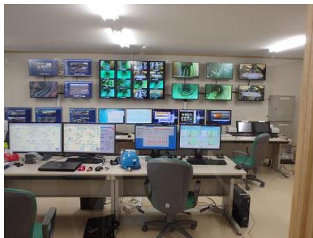
双葉工区受入・分別施設の状況の確認
