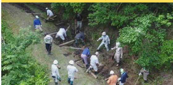
わだち掘れ箇所に土のう袋を充填
