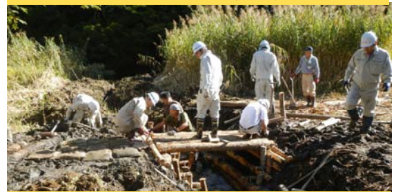
現地の木を伐り出して桁橋を架設
