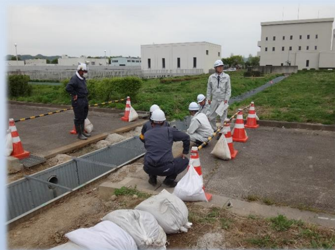
現場内の安全対策確認状況
