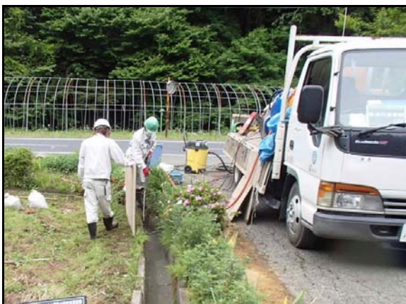
側溝除染作業中
