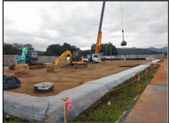
仮置場造成・搬入状況
