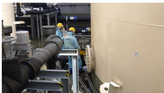
(写真1) 弁の操作状況
