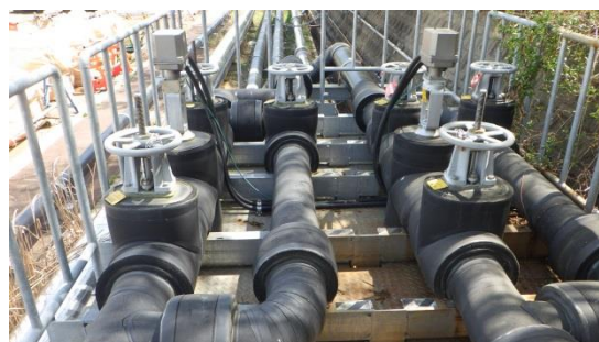
(写真2) バルブユニットの状況
