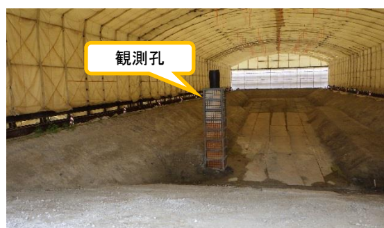
(写真3) 第4槽内部
