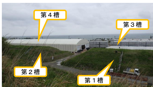
(写真1) 覆土式一時保管施設エリアLの概観
