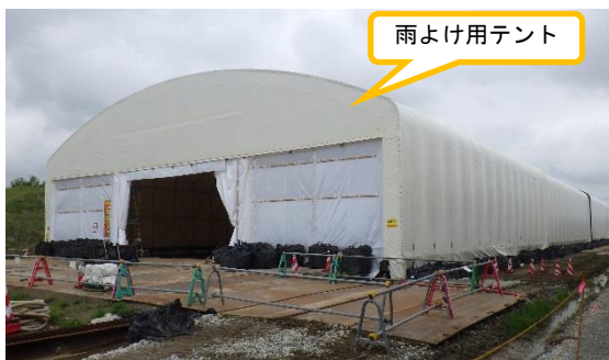
(写真2) 第4槽外観
