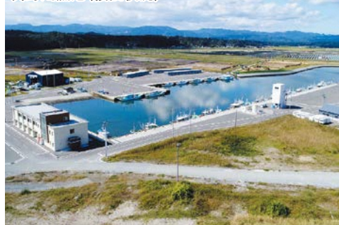
真野川漁港(復旧状況)
