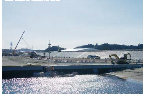
富岡漁港(復旧状況)
