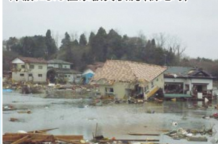
津波による住家被災状況 (新地町)
