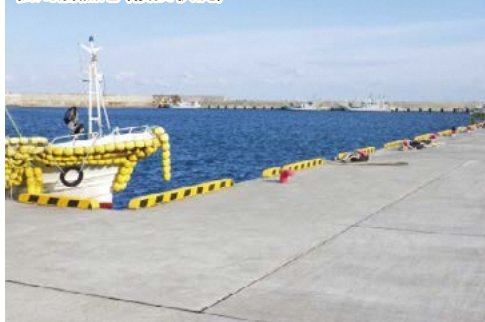
松川浦漁港(復旧状況)
