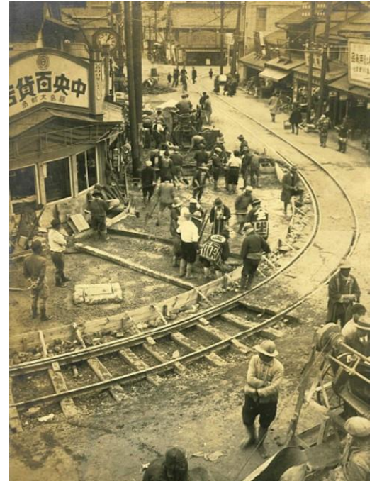
昭和10年頃の施工状況写真 ＜コンクリート工事施工中の1枚＞ 現在のレンガ通りと県庁通りの交差点の位置
