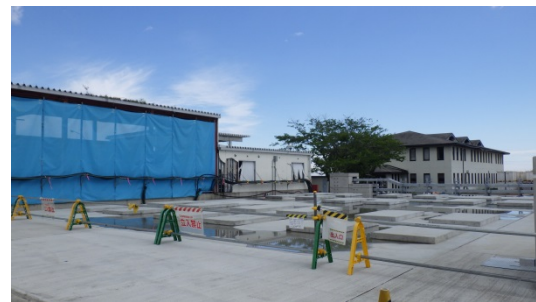
(写真4-2) 建物解体後の状況 (平成30年6月1日撮影)
