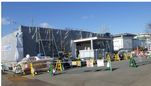
(写真4-1) 建物解体前の状況 (平成29年11月27日撮影)
