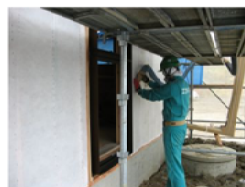
壁断熱材吹込み
