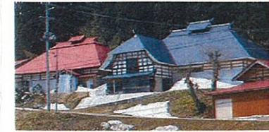
福島に多くみられる茅葺き屋根の上に鉄板をかぶせた民家の屋根形態
