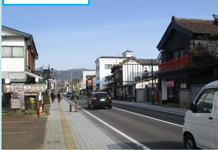
施工後・下の区
