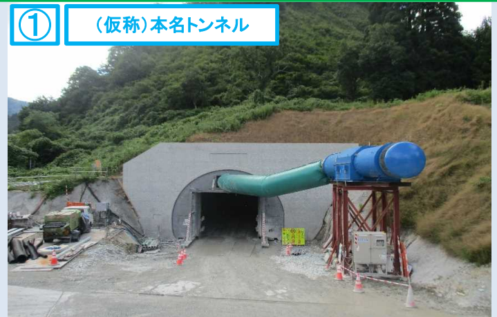
① (仮称)本名トンネル
