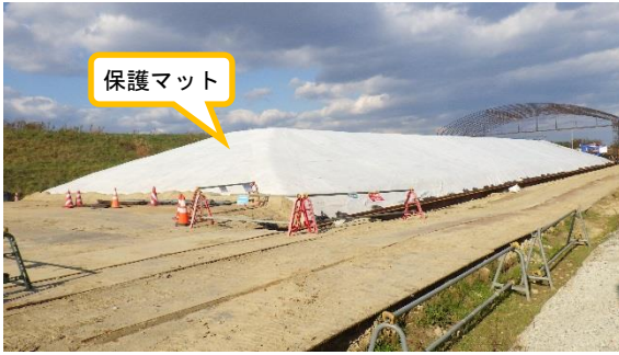
(写真 2) 第 4 槽の状況② (南東側から撮影)
