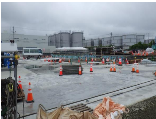
(写真3-1) 基礎工事の様子
