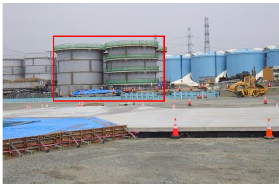
(写真1-1) 撤去前フランジ型タンク。平成30年4月27日撮影
