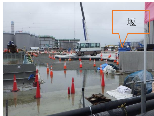
(写真3-2) 基礎工事の様子。小型バス 駐車場所付近まで基礎工事が進捗し ている。また、右側に堰が見える。
