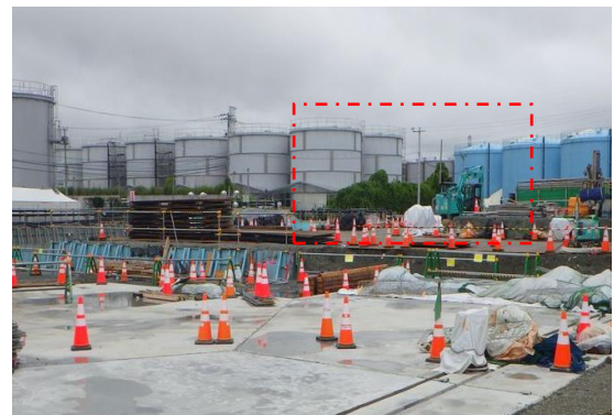
(写真1-2) フランジ型タンクが撤去された様子(点線内)。平成30年7月6日撮影。(写真1-1)の赤枠内のタンクが撤去されていた。
