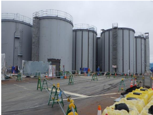
(写真2) 建設中の溶接型タンク
