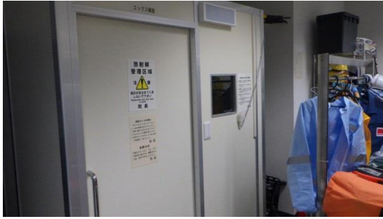
(写真3-3) レントゲン室
