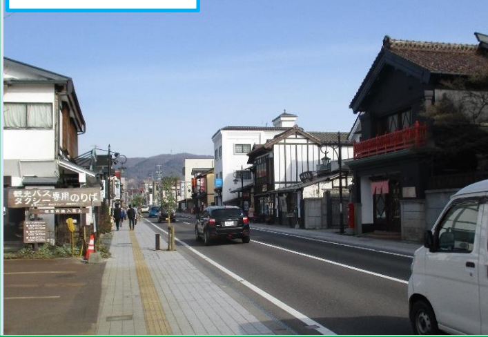
施工後・下の区
