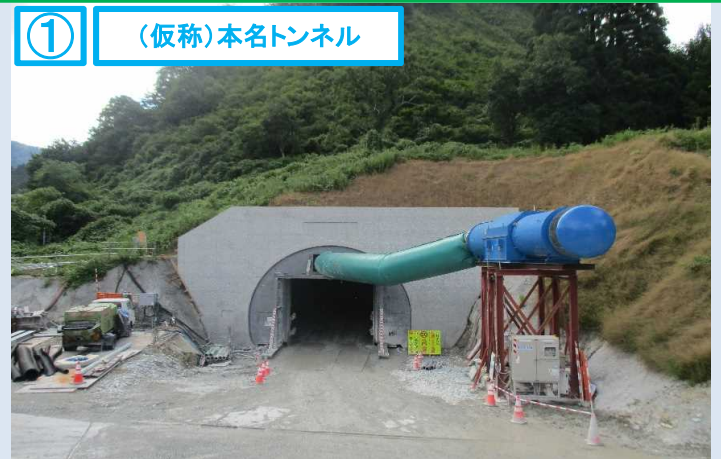
① (仮称)本名トンネル
