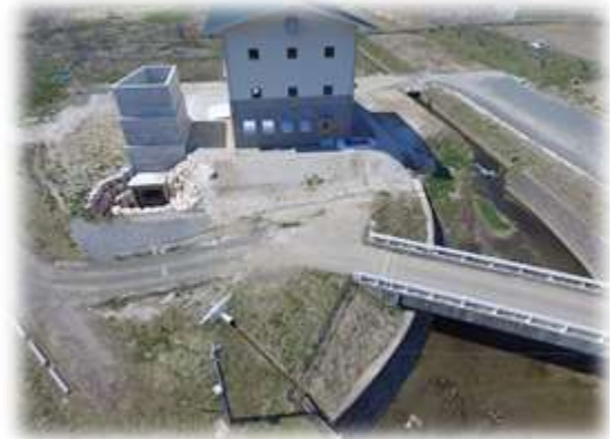
伊達市梁川町五十沢地区の排水機場の様子
