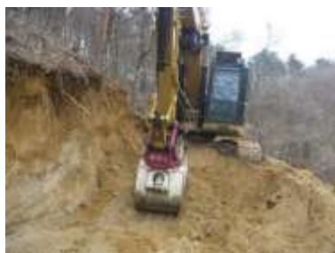
作業道の作設の様子
