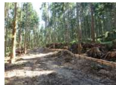
土砂流出防止のための丸太筋工
