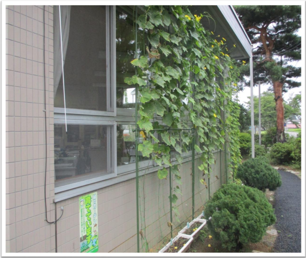
泉崎村立泉崎第一小学校 平成30年9月4日撮影
