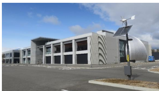
ハイブリッド街路灯 (福島県環境創造センター（三春町）)
