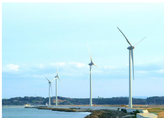
万葉の里風力発電所（南相馬市）
