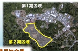
工業団地全景
