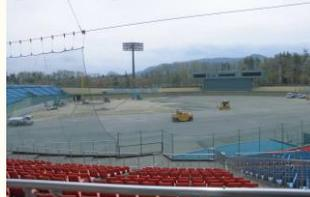
グラウンドの人工芝施工部分の路盤の整備等を行っています。路盤整備完了後、人工芝の設置を行います。
