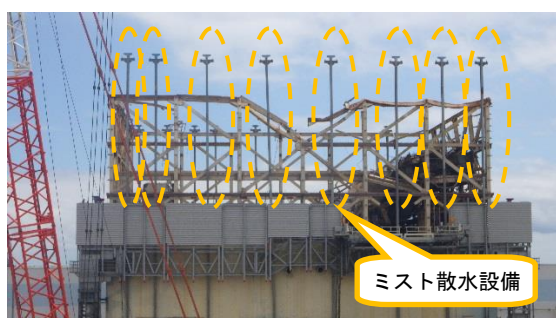
(写真1) 本日確認した1号機原子炉建屋上部の様子
