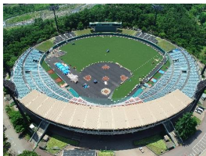
人工芝設置工事（R元年6月末）
