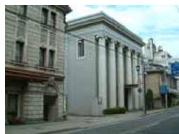
▼ 滝谷建設工業(株)会津若松店社屋
