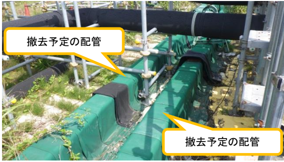
(写真1-3) 撤去予定の配管の一例
