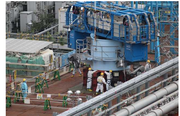
排気筒頂部ブロック着座状況
