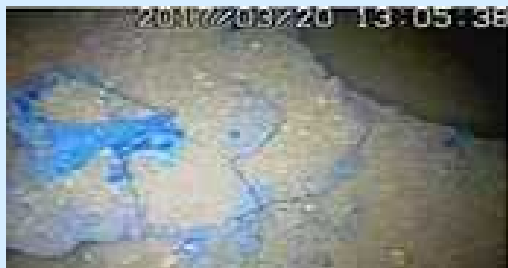
ペDESTAL外側の状況
