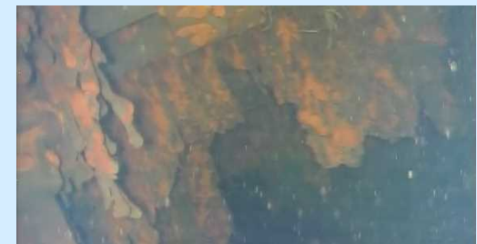
ペDESTAL内側の状況
