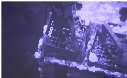
燃料取り出しの様子
