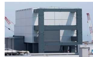
4号機原子炉建屋外観
