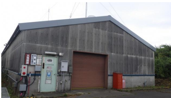
(写真1-2) No. 4 屋内危険物倉庫
