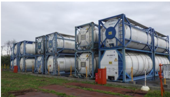
(写真2-2) No. 2 危険物屋外貯蔵所
