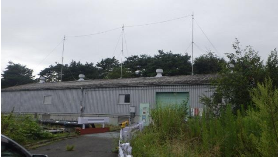
(写真1-3) No. 5 屋内危険物倉庫
