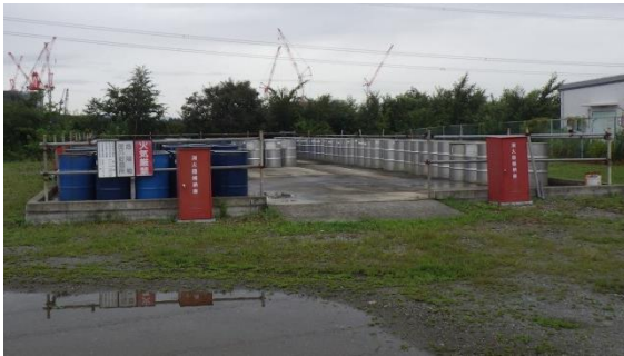
(写真2-1) No. 1 (A) 危険物屋外貯蔵所
