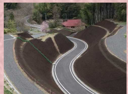
基幹農道整備 中石井3期地区
