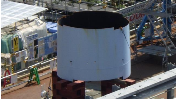
(写真1-2) 仮置きされていた2ブロック目の状況
