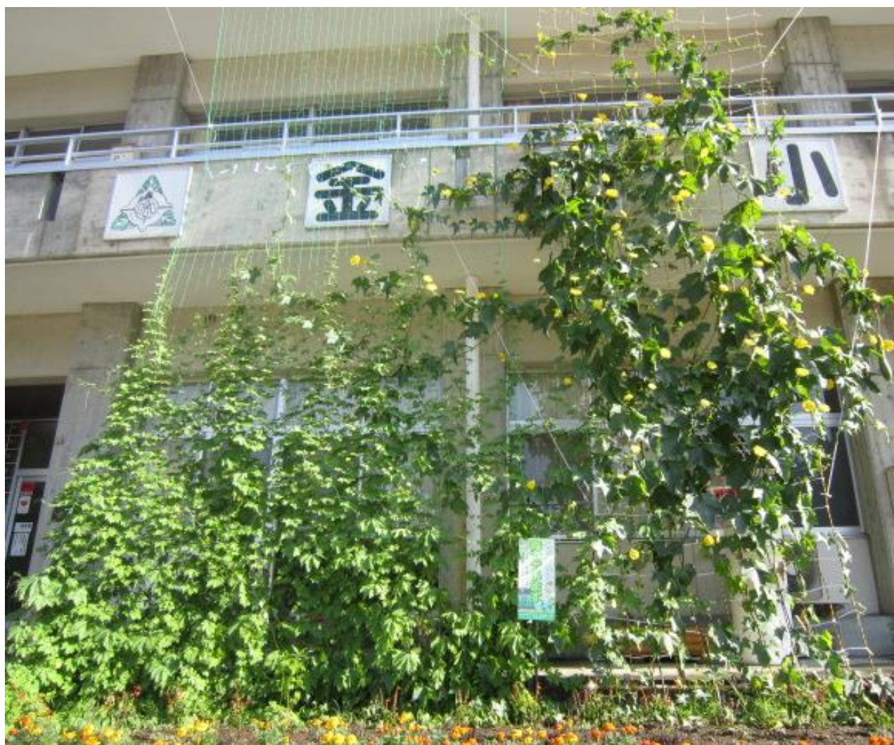
金山町立金山小学校 令和元年 8月撮影
